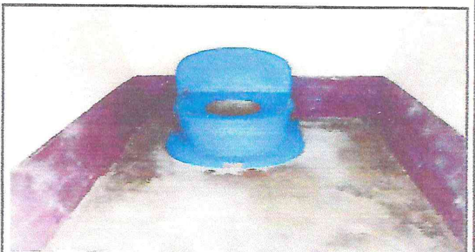
Foto 4: Mantenimiento de Drenaje y Agua. Modulo 6.
