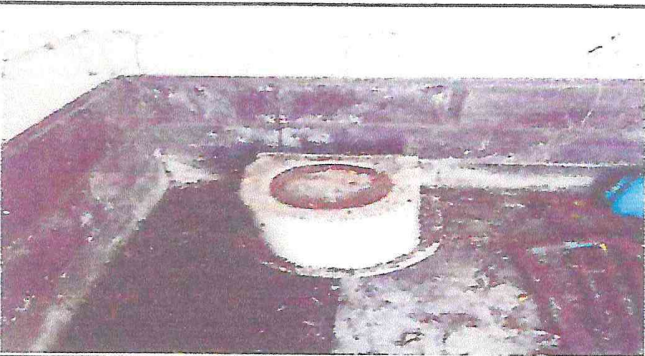
Foto 3: sustitución de tetrinas por inodoros , modulo 6
