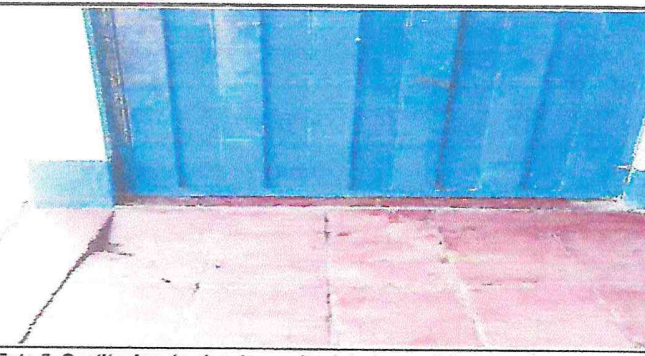
Foto 5: Sustitución de piso de granito, interior modulo 1, 2 y 4
