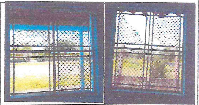
Foto 6: Sustotucion de balcones modulo 1,2, 3 y 4
